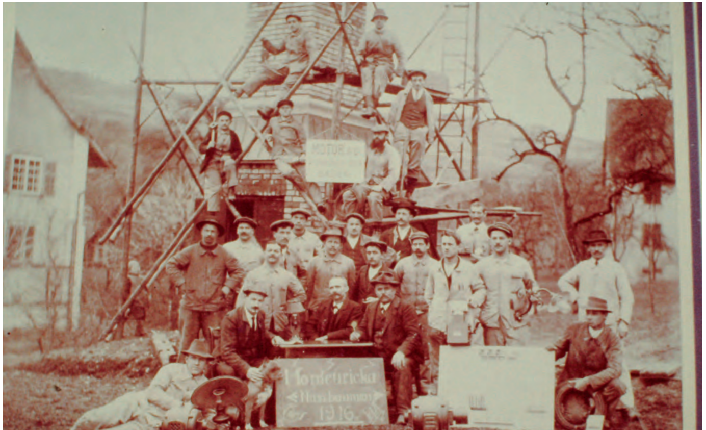
Aufrichtefest vom Transformer als im Jahr 1916 Elektrizität ins Dorf kam, Foto von Margrith Isenring
