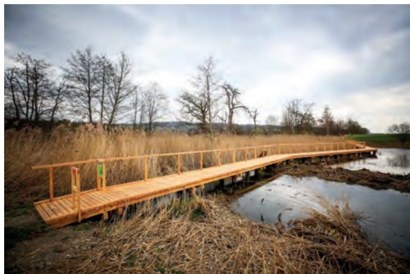
Der neue Steg über den Nussbaumersee
